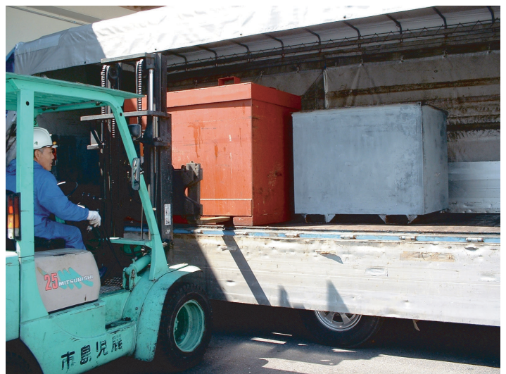
混載の場合のトラックへの積み込み
